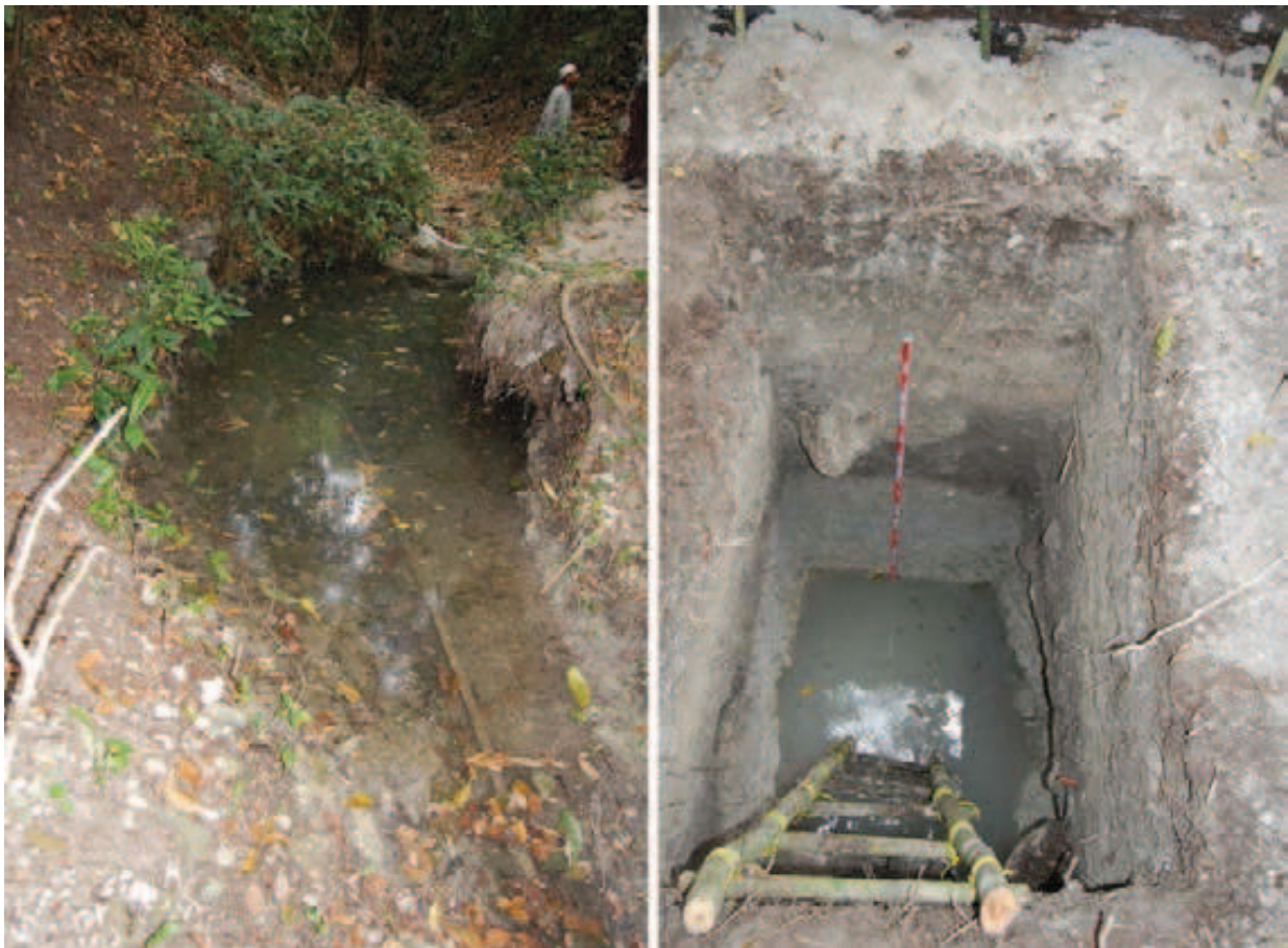
Figura 9. Manantial en Naranjo (izquierda). Pozo en el tanque superior del Reservorio del Templo (derecha).
